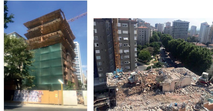
GÜRSOY İNŞAAT Kalamış Şantiyesi Yıkım Projemiz
