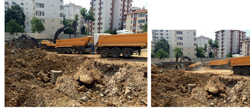
Elbey grup Erenköy Şantiyesi Hafriyat Projemiz
