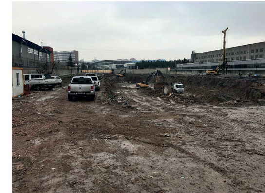
SARITAŞ ÇELİK A.Ş. Hafriyat projemizde 60.000 m3 hafriyatı bitirilerek teslim edilmiştir.
